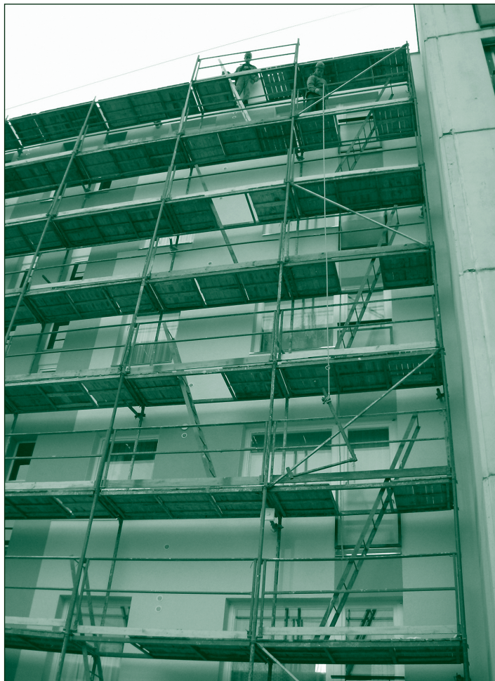
A Wlasics sétány 9–11. külső szigetelése kevesebb, mint három hónap alatt lezajlott. A kivitelezés zökkenőmentesen folyt.
