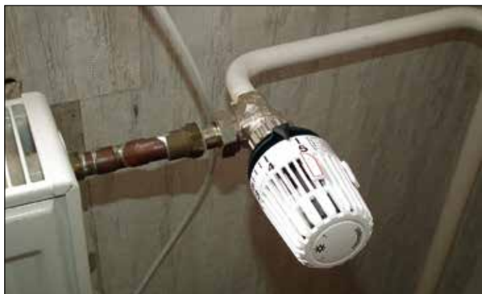
Termosztatikus radiátorszelepeket, és negyedik generációs fűtési költségosztókat szereltek fel a Wlassics 8–10-ben.
