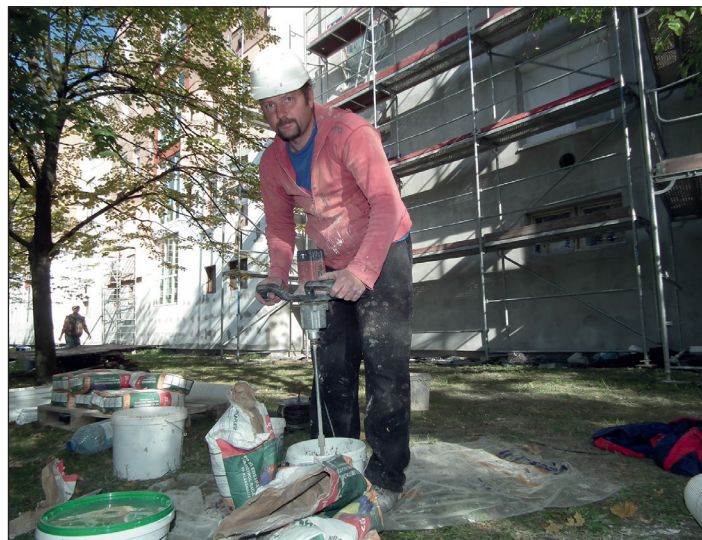
A Szabó Pál tér 9-11. szám alatt éppen ezekben a hetekben végzik el a tömb utólagos komplett hőszigetelését.
